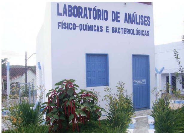
Figura 13 - Fachada da Estrutura do Laboratório da ETA de Vereda; EMBASA 2016.
