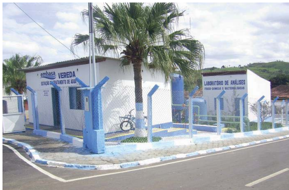
Figura 12 - Vista da ETA de Vereda; EMBASA 2016.
