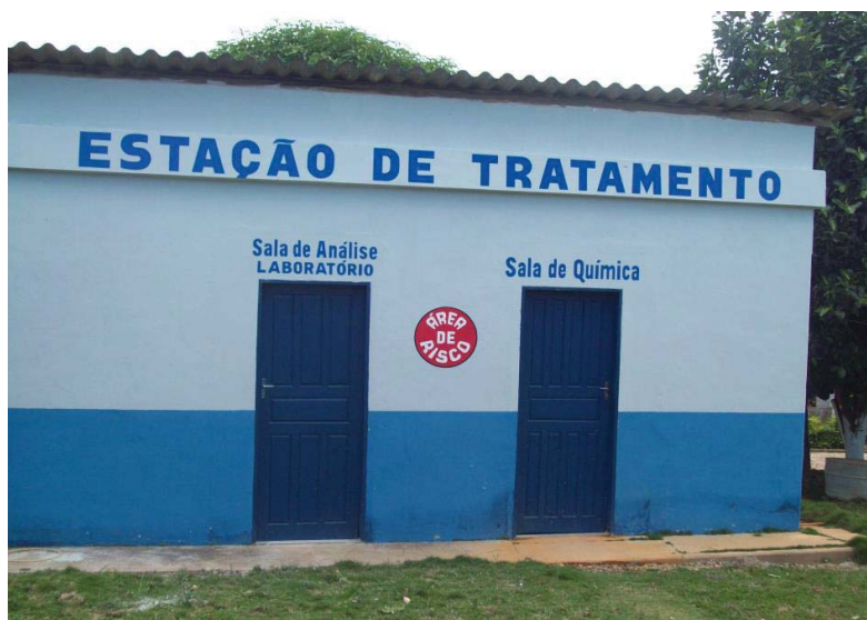
Figura 20 - Fachada da Estrutura do Laboratório da ETA de Cruzeiro do Sul; EMBASA 2016.
